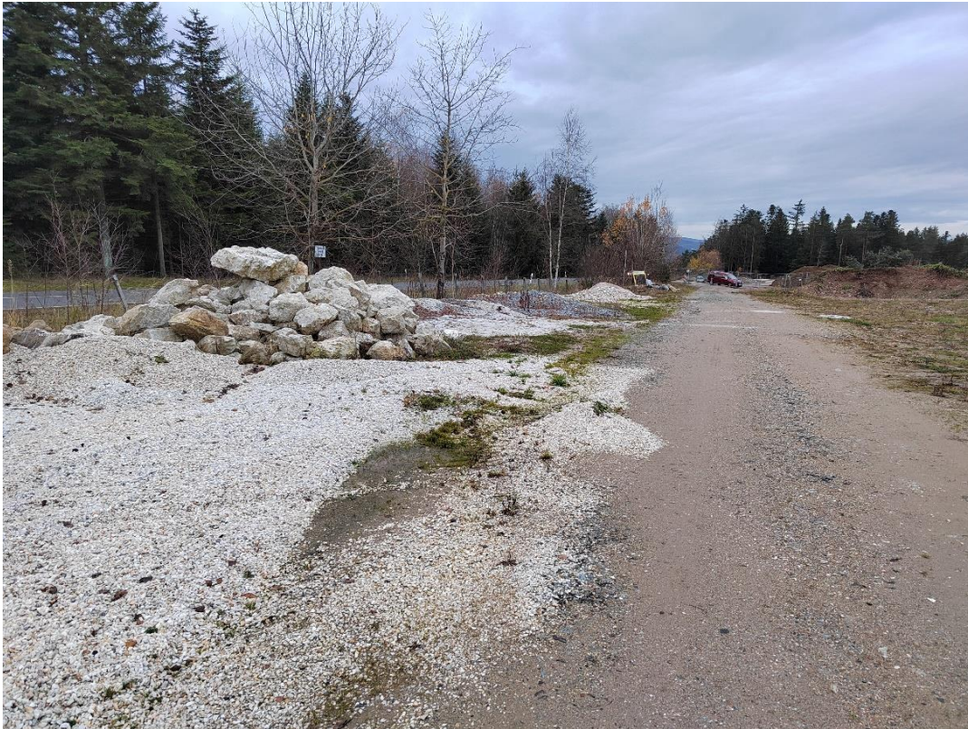
Abbildung 7: Parallel zur B85 verlaufender Fahrweg mittig im UG. Zwischen Fahrweg und B85 mit Gehölzen bestandener Entwässerungsgraben und Stein-/Kiesaufschüttungen. Blick Richtung Nordwesten.
