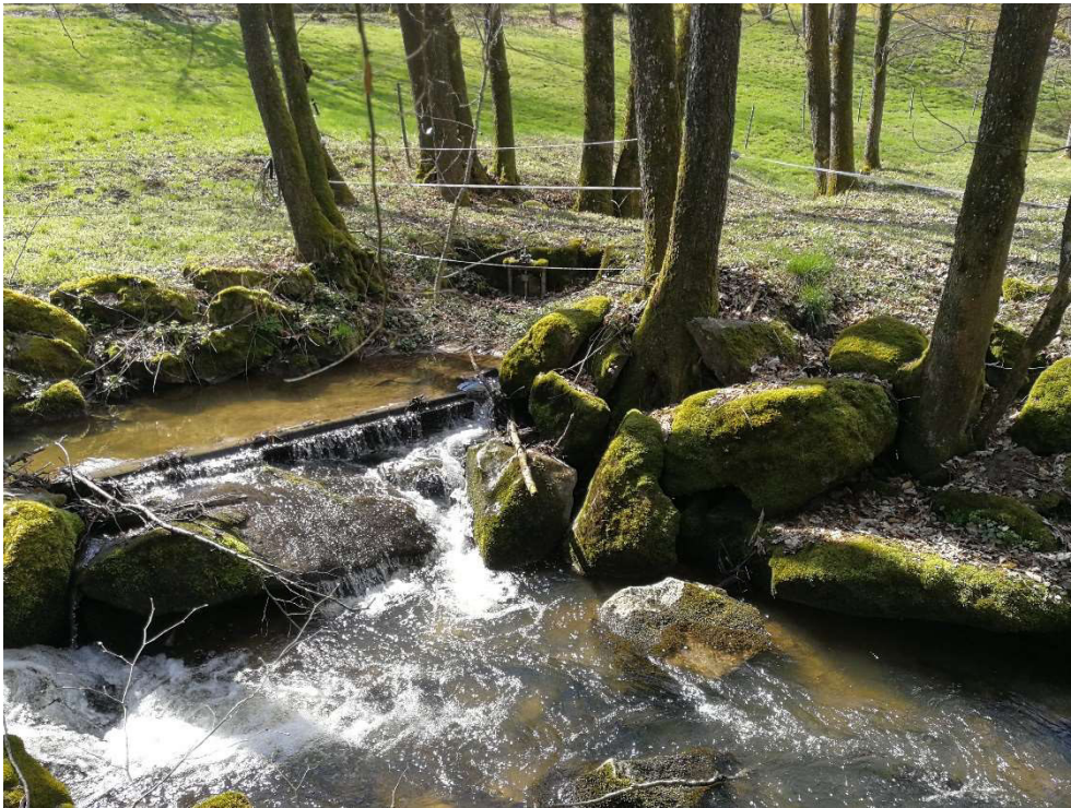
Bestehende Wehranlage WKA Wandelmühle, Wandelbach
